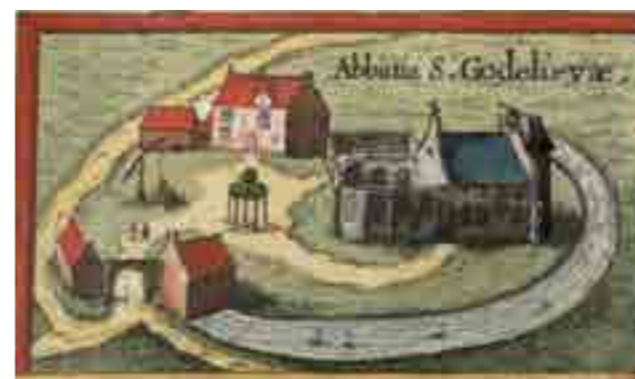
Op deze mooie tekening van de Vlaamse kanunnik Antonius Sanderus zien we de Sint-Godelieveabdij in Gistel circa 1641 met de voornaamste gebouwen, gronden en waterput. De abdijsite is als een microkosmos afgesloten van de vijandige plattelandsbuurt door een beschermende slotgracht.
