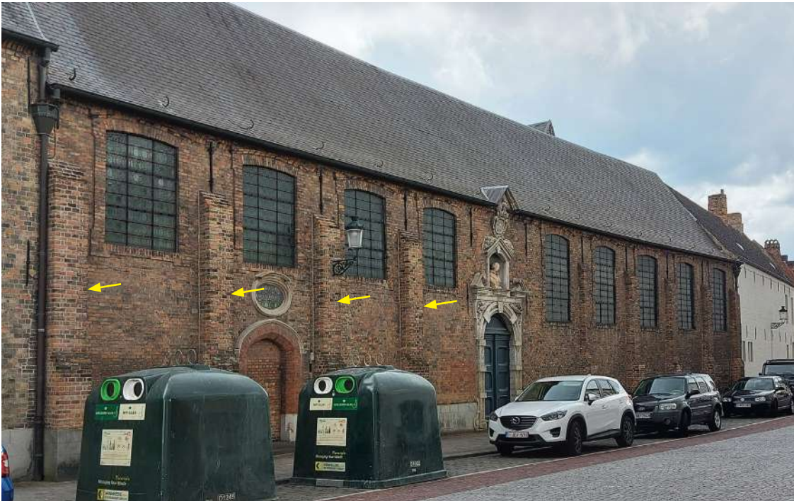
KAPEL - straatgevel (ca. 1626 / verbouwd ca. 1722)
